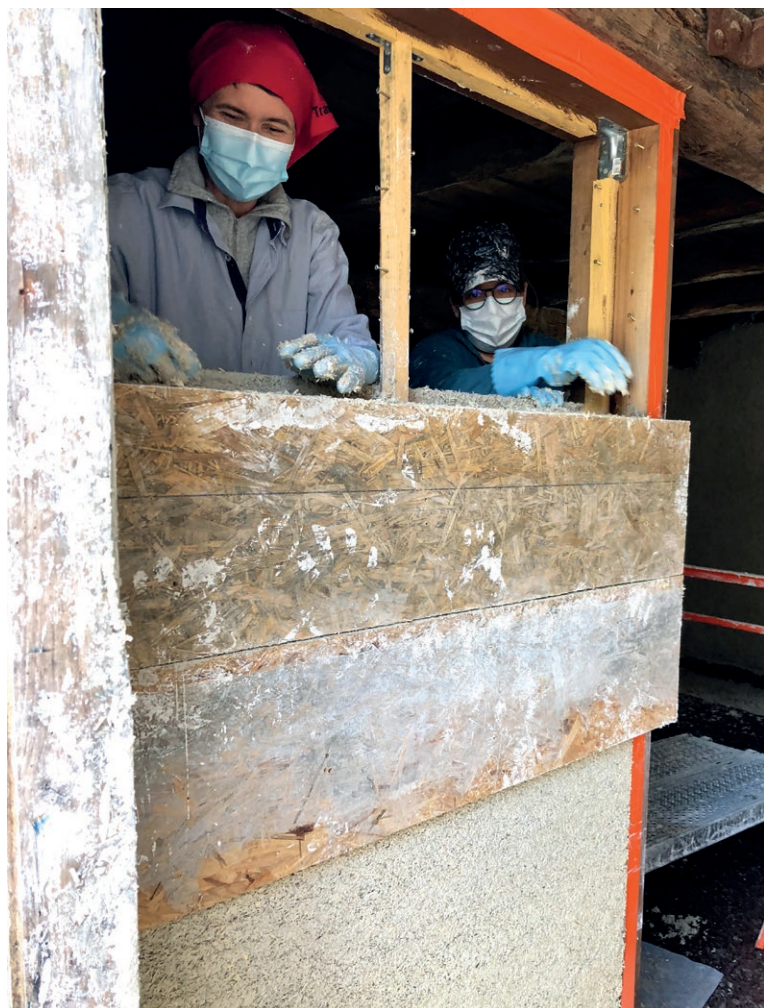
Formation écomatériaux : cloison chaux-chanvre.
