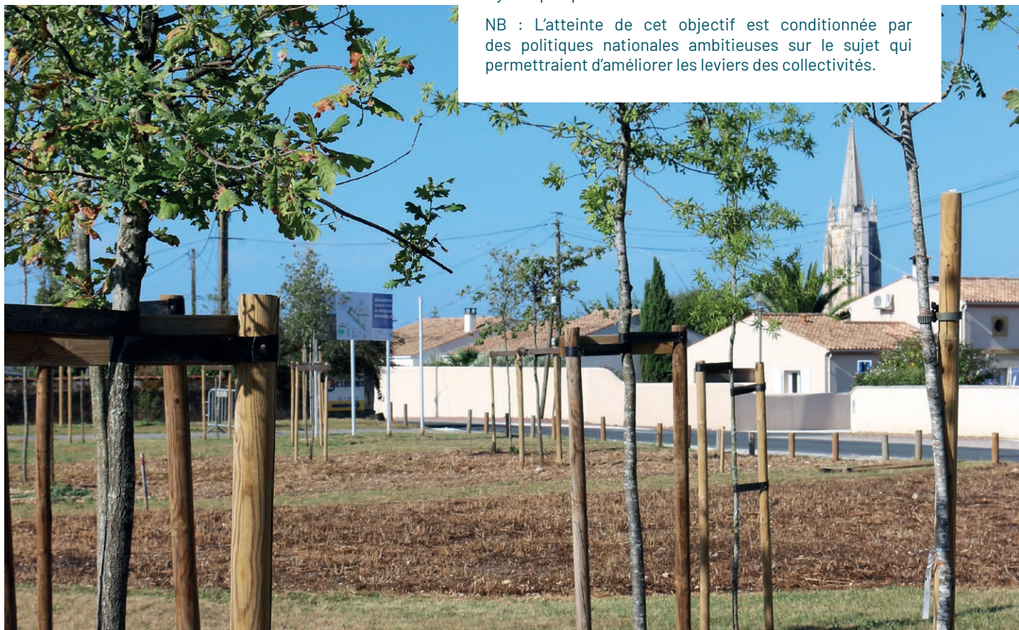
La Marquina - écoquartier en construction à Marennes - 2021.
