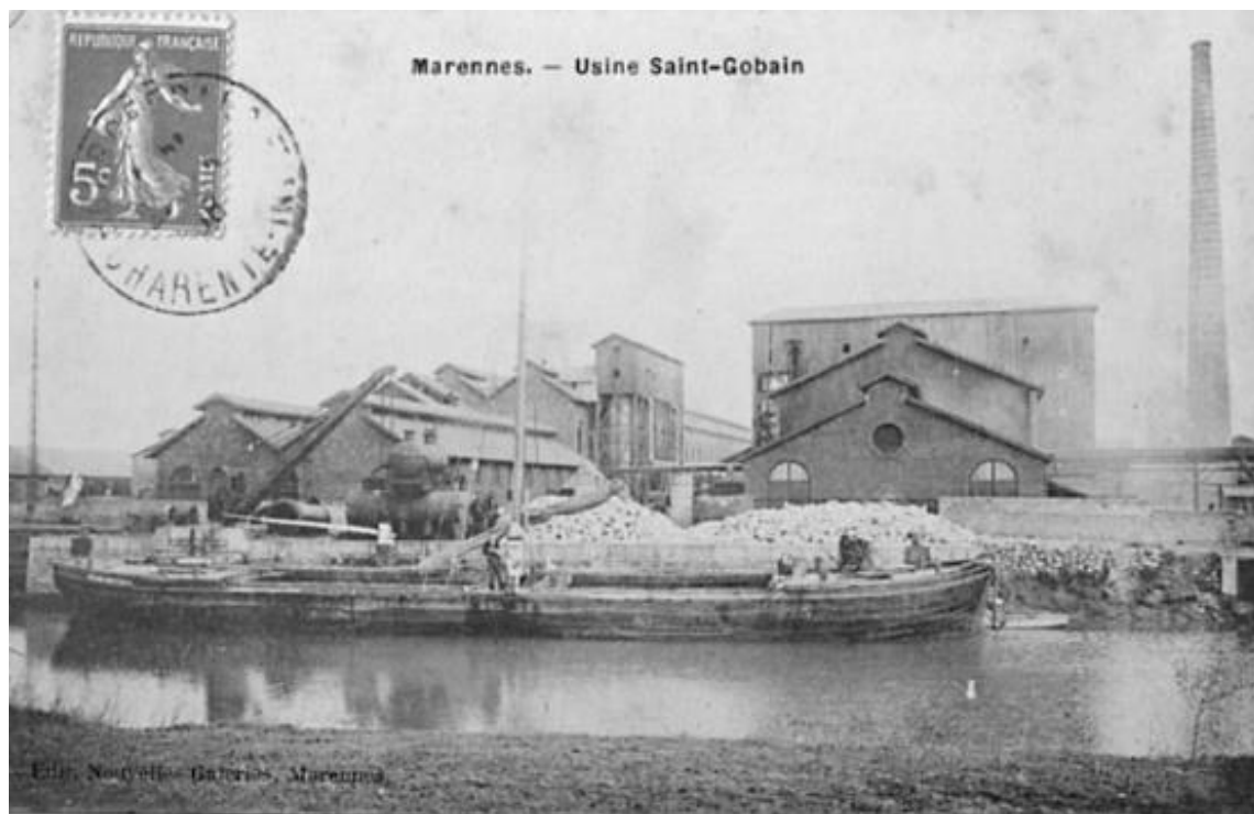
Un bateau sur le canal, devant l'usine Saint-Gobain, à Port-de-Seynes, avant 1908
