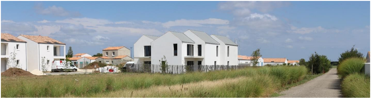
Ecoquartier de la Marquina (en construction - 2022) – Marennes-Hiers-Brouage
