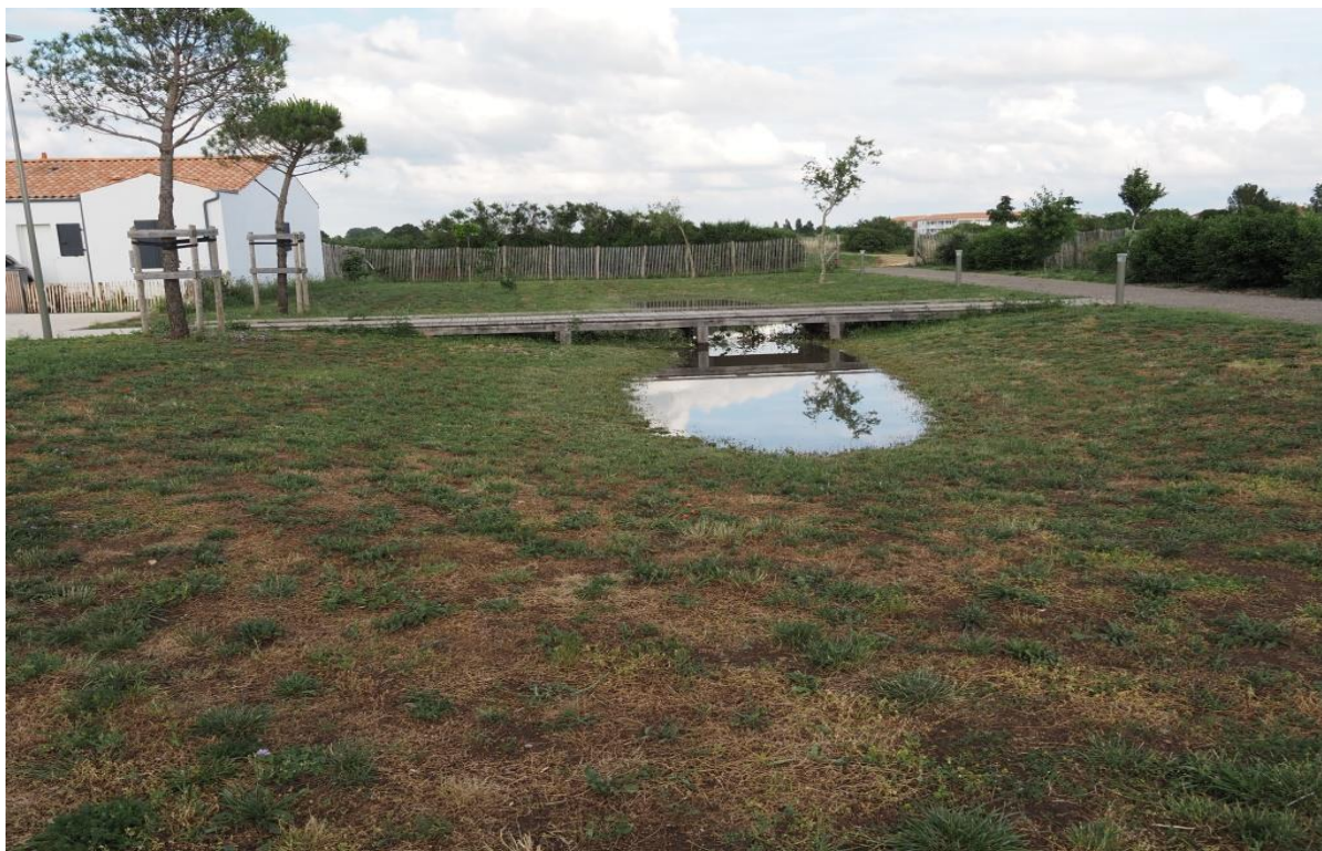
Marenes, écoquartier récent de « La Marquina » : en bordure de lotissement, des noues (ici au lendemain d'un fort orage d'été), et un accès pédestre direct à une zone plus naturelle. © : IODDE
